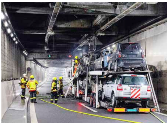
LKW-Brand im Sonnenbergtunnel, 05.12.2022
