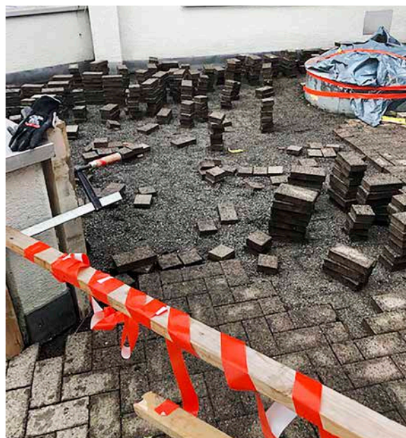
Sanierung Vorplatz bei Feuerwehrgebäude Littau
