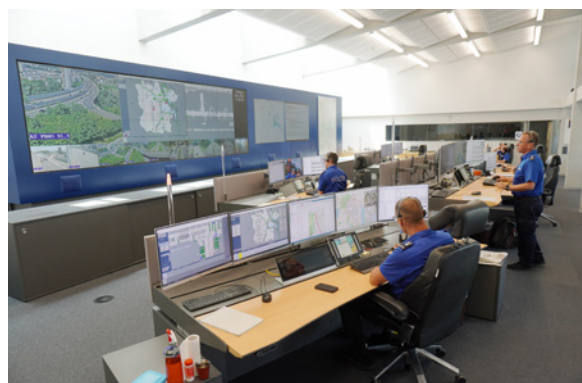
Einsatzleitzentrale der Luzerner Polizei
