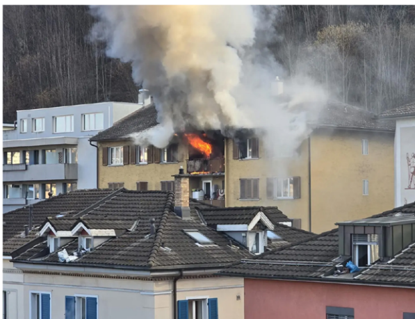
In diesem Haus brannte es.
