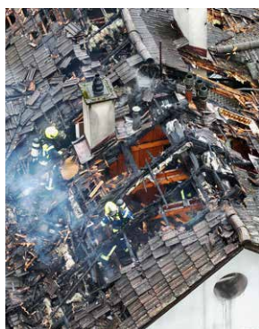
Titelseite: Brand Gebäude Baselstrasse 6. Februar 2026
